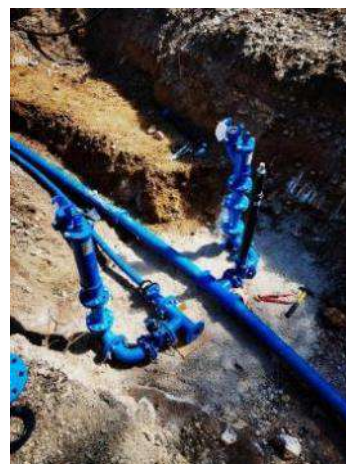
Montaža podzemnih hidrantov
