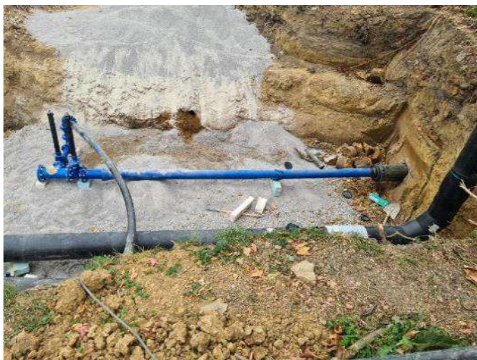
Podboj pod železniško progo na Tomšičevi cesti
