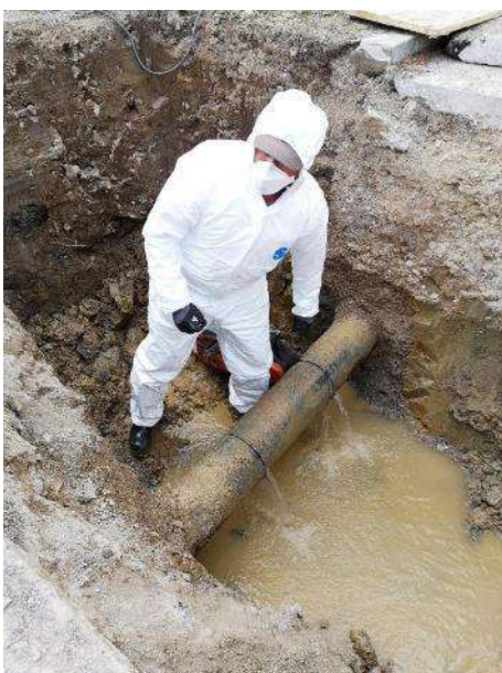
Izdelava odcepa na stari azbestni cevi
