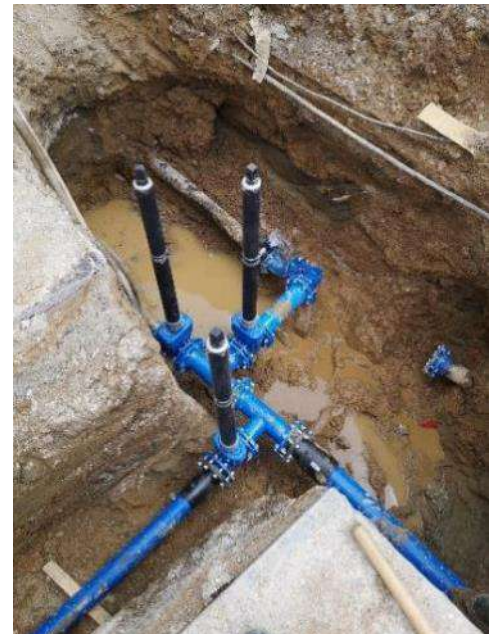
Navezava na staro cev, odcep ter priprava za nadaljevanje obnove
