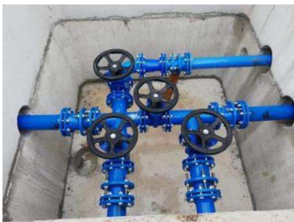
Izgrajen krmilni jašek
