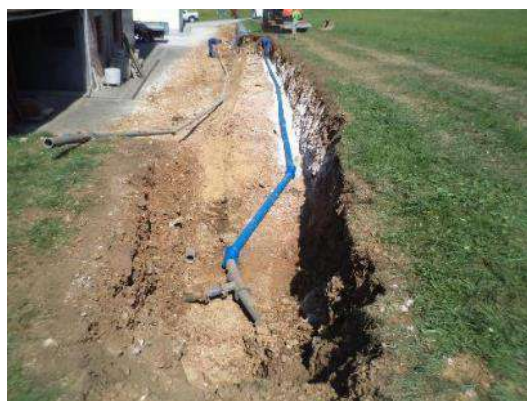
Montaža podzemnih hidrantov
