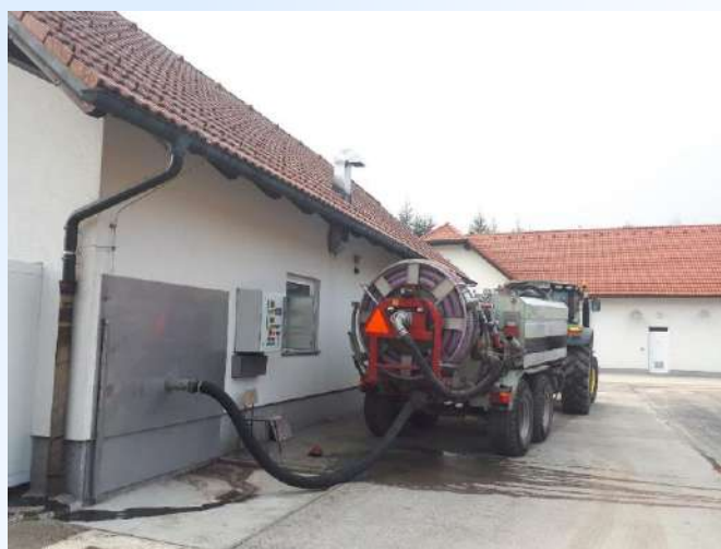
Slika 27: Praznjenje cisterne v zalogovnik grezničnega blata na ČN Ribnica
