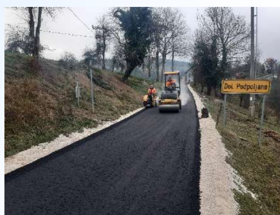
Slika 47: Asfaltiranje ceste Dolenje Podpoljane
