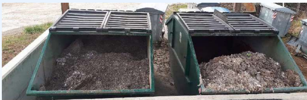
Slika 19: Zabojniki za začasno skladiščenje odpadkov iz grabelj, sit in peskolova
