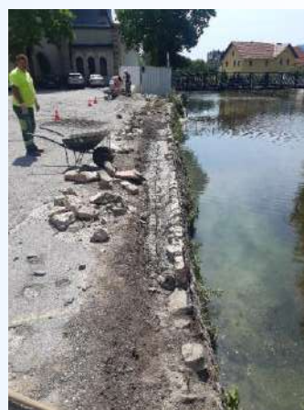
Slika 39: Oporni zid Ob Bistrici
