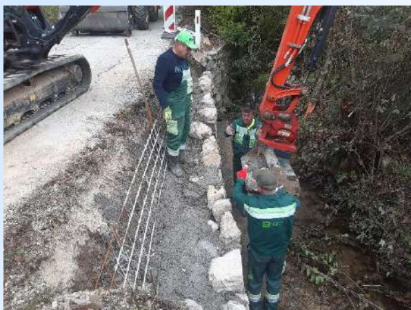
Slika 38: Oporni zid Črni Potok
