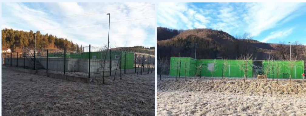
Slika 21: Čistilna naprava Sodražica
