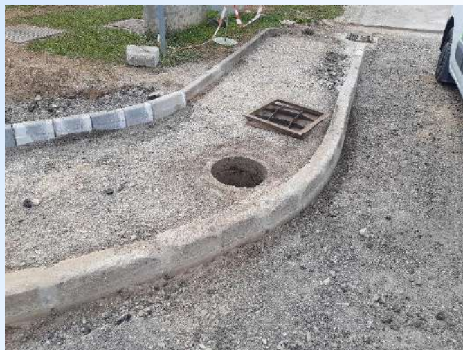
Slika 37: Polaganje robnikov in popravilo jaška
