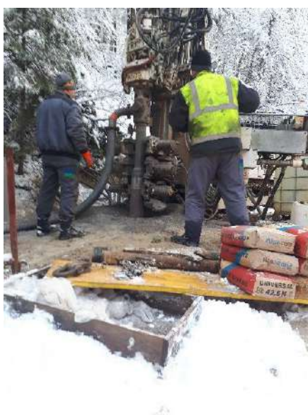
Izgradnja vrtine na Gori.
