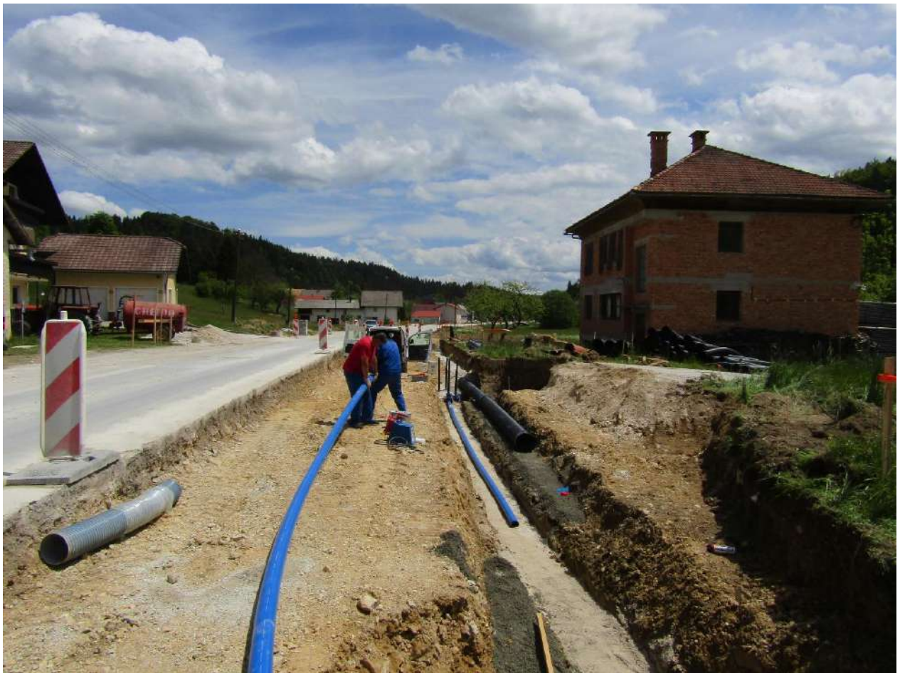
Obnova ceste in vodovoda v Žimaricah.
