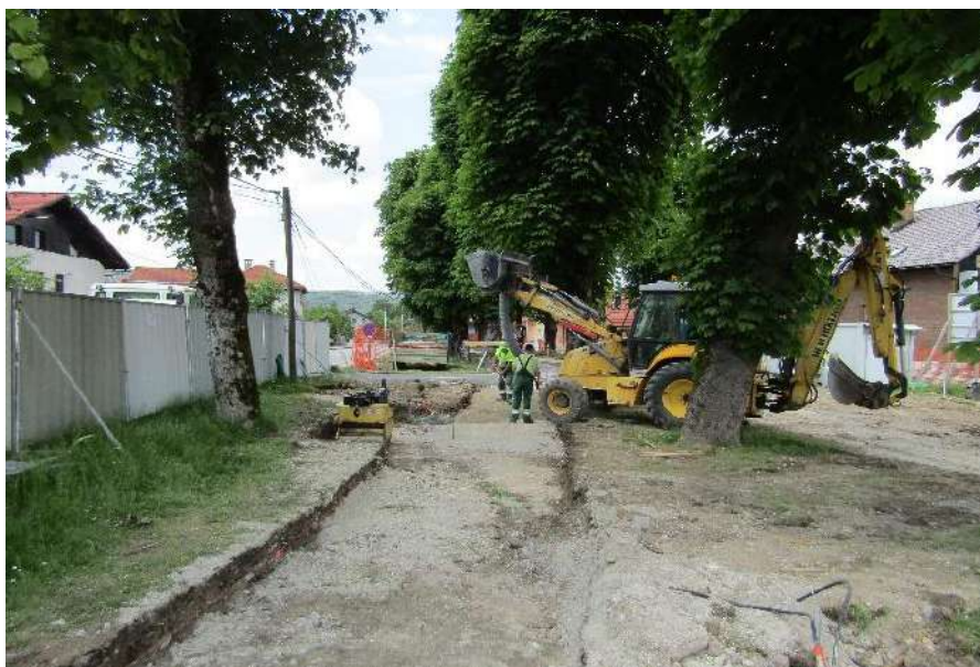
Obnova Kostanjevega parka.
