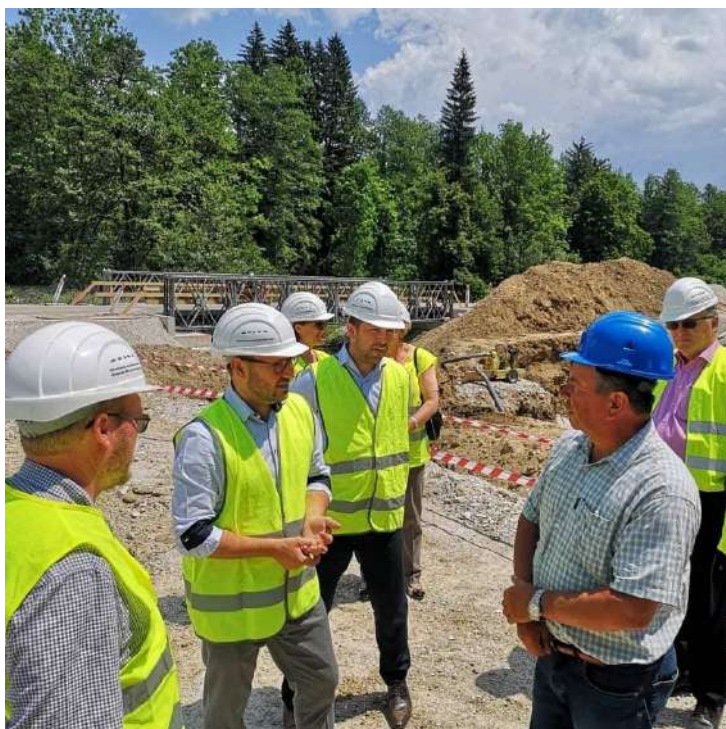
Obisk ministra Vrtovca na gradbišču v Žimaricah.
