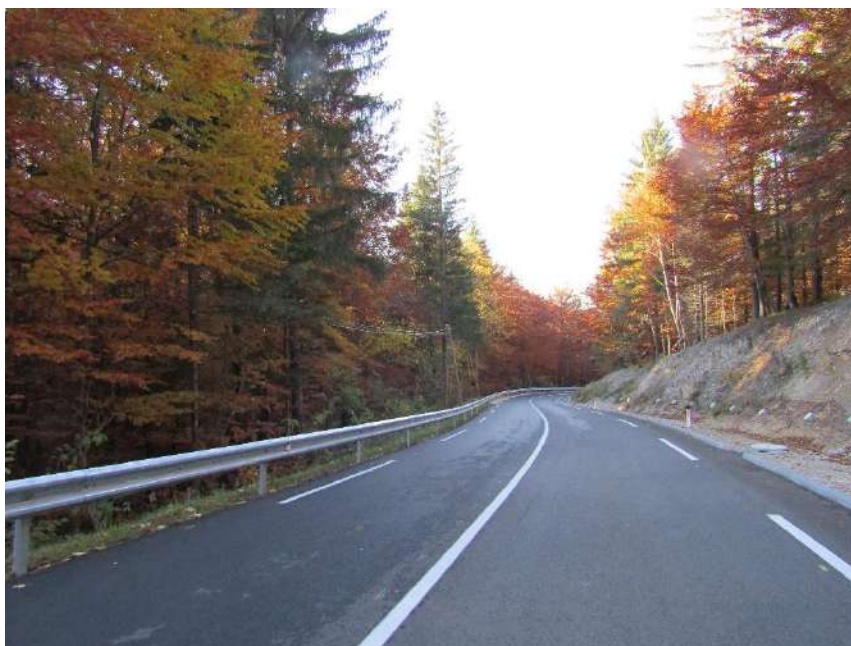
Prenovljen odsek ceste Sodražica – Loški Potok.
