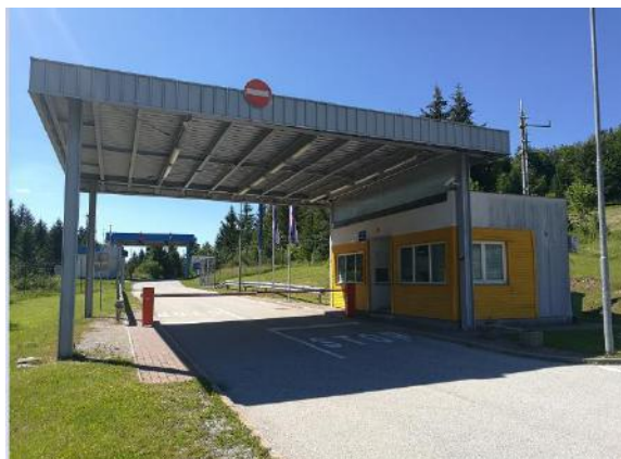
Slika 2: Mejni prehod Novi Kot
