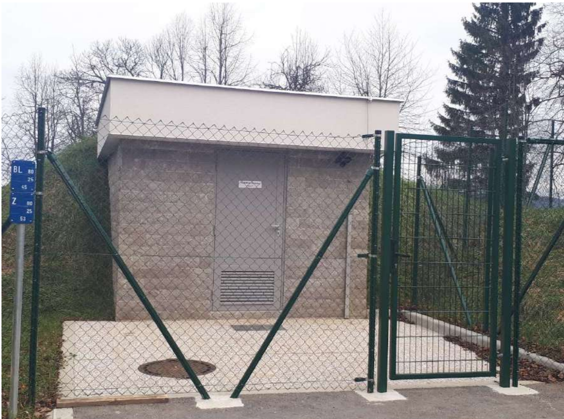
Nov vodozadrževalnik Sinovica, ki je bil zgrajen l. 2019.
