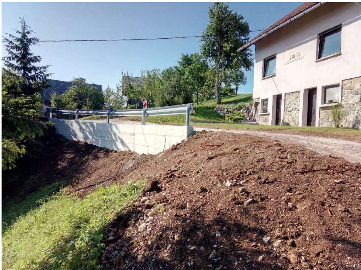
Izgradnja opornega zidu v vasi Kržeti poleti 2019.
