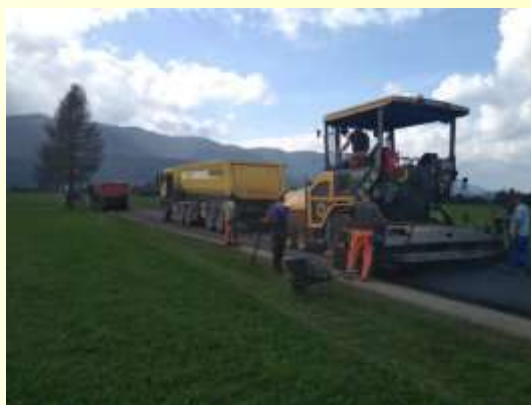
Slika 55: Zemeljska dela za javno razsvetljavo Slika 56: asfaltiranje ceste v Lipovec
