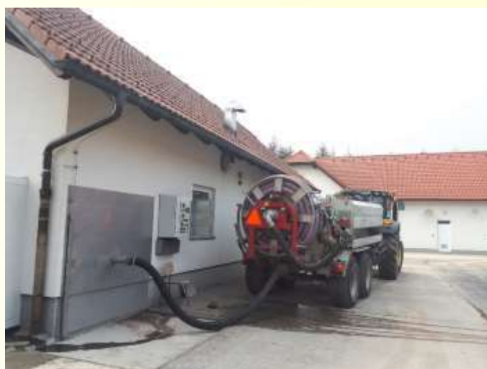
Slika 40: Praznjenje cisterne v zalogovnik grezničnega blata na ČN Ribnica
