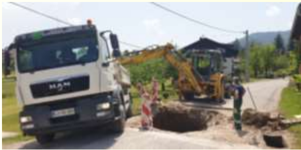
Slika 48: Sanacija udara v Dolenji vasi
