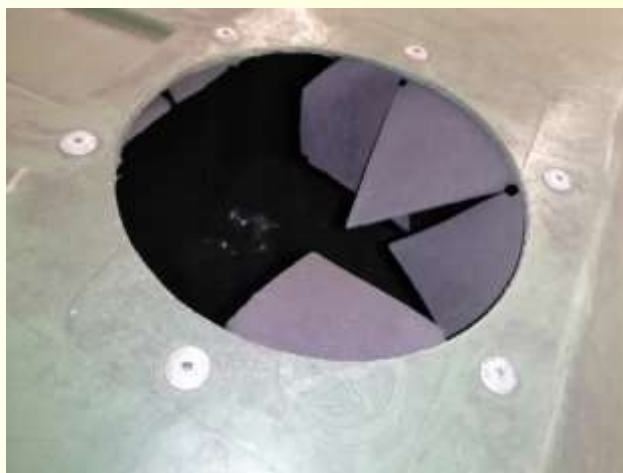
Slika 14: Poškodba gume - rozete na zabojniku za steklo
