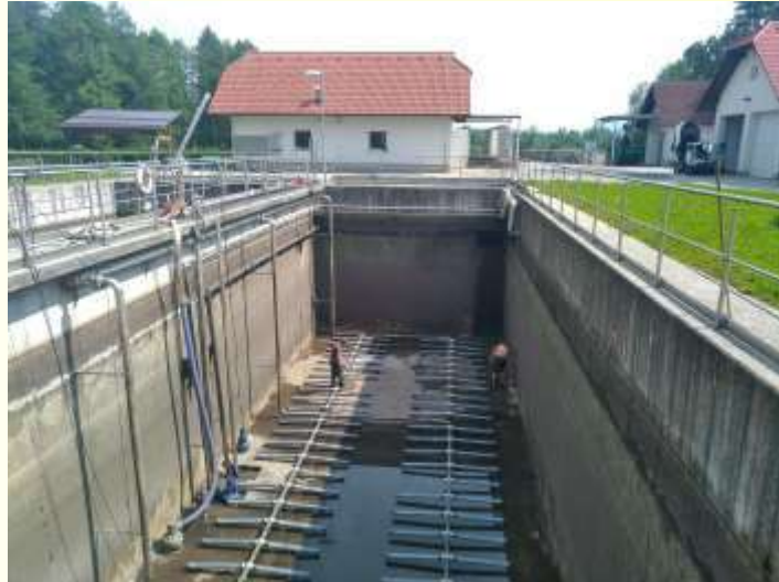
Slika 30: Čiščenje sekvenčnega bazena zaradi zamenjave difuzorjev
