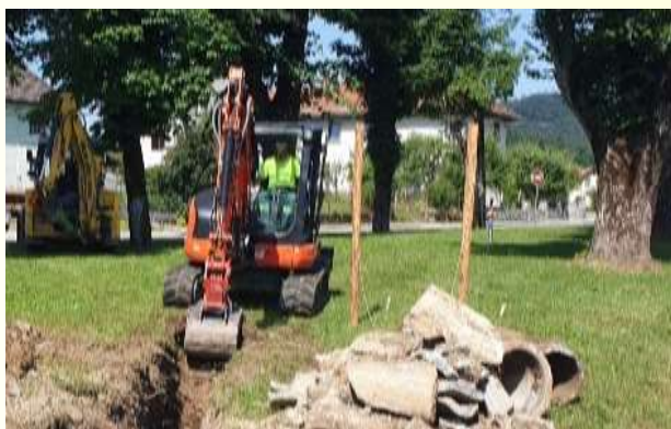
Slika 53: Sanacija kanalizacije v Sodražici
