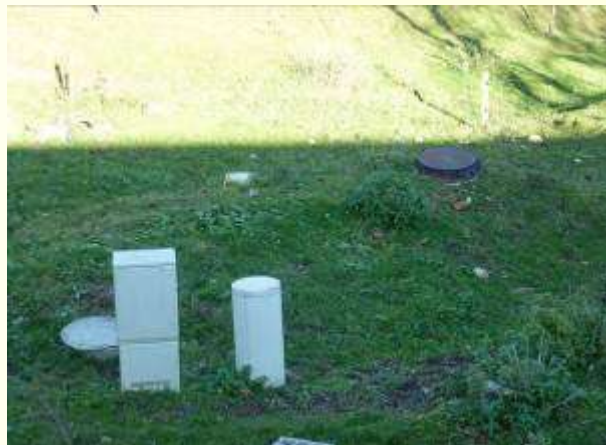
Slika 35: Mala čistilna naprava Novi Pot
