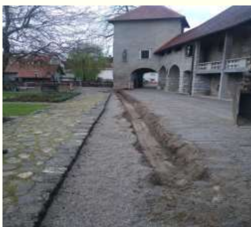
Slika 59: Izgradnja komunalnih vodov
