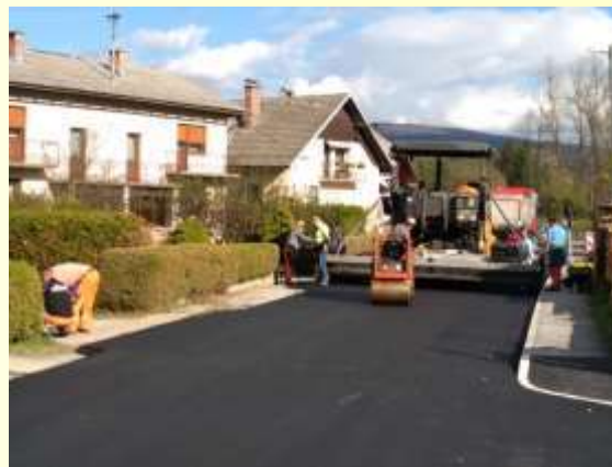
Slika 51: Asfaltiranje Opekarske ceste
