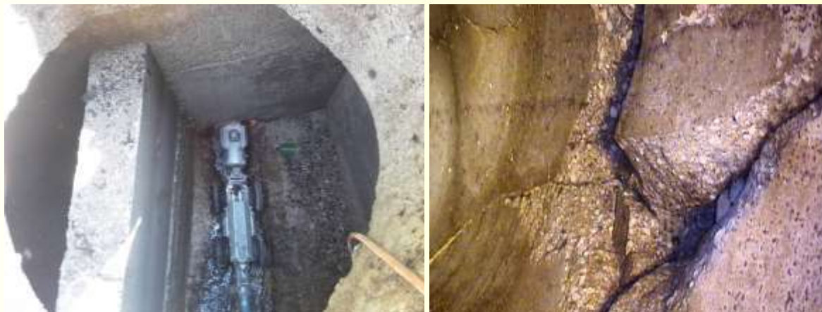
Slika 38-39: Snemanje poškodovane kanalizacije
