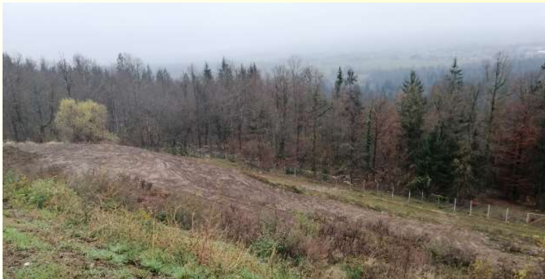
Slika 25: Izvajanje zaključnih del na deponiji za inertne odpadke
