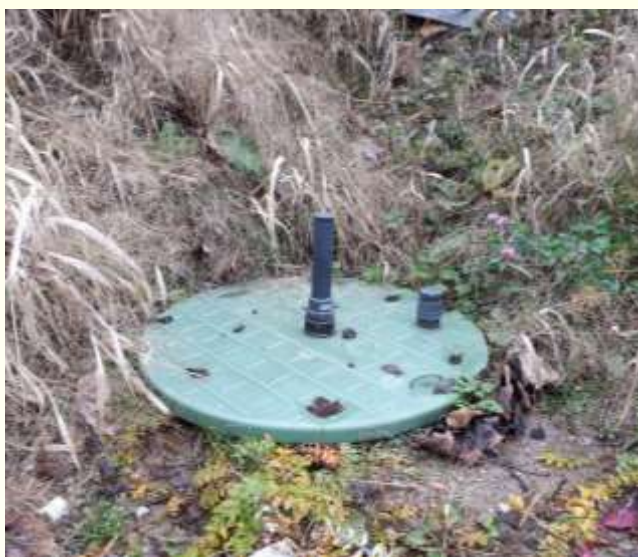
Slika 24: Cisterna za zbiranje izcedne vode iz deponije nenevarnih odpadkov Mala gora
