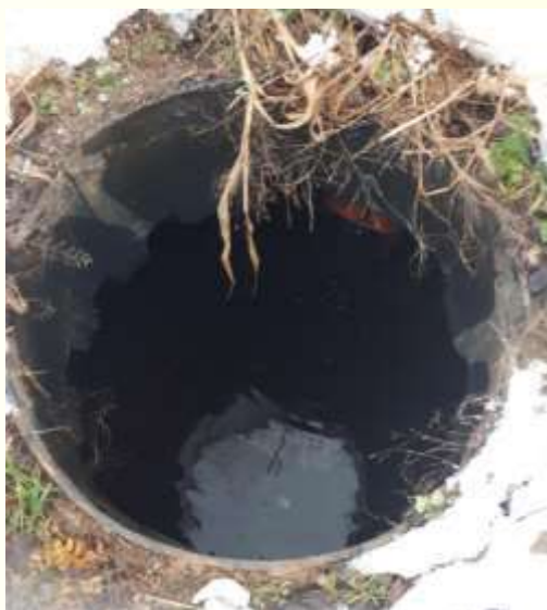
Slika 24: Cisterna za zbiranje izcedne vode iz deponije nenevarnih odpadkov Mala gora
