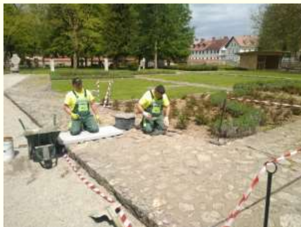
Slika 60: Sanacija temelja gradu
