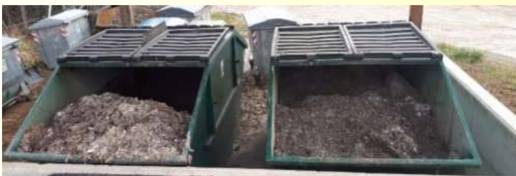
Slika 29: Zabojniki za začasno skladiščenje odpadkov iz grabelj, sit in peskolova
