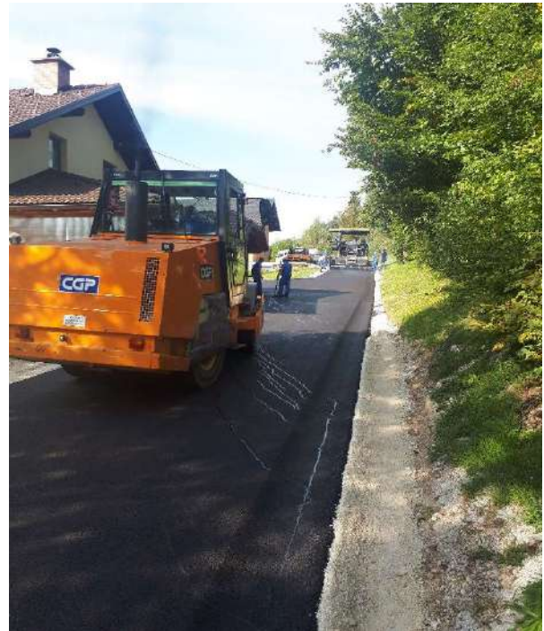
Gradnja novega vodovoda in obnova ceste na Hosti.
