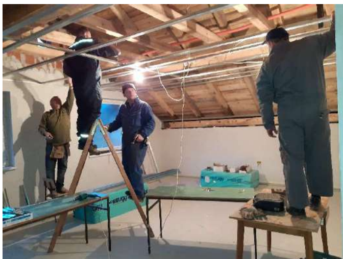
Obnova gasilskega doma v Zamostcu.
