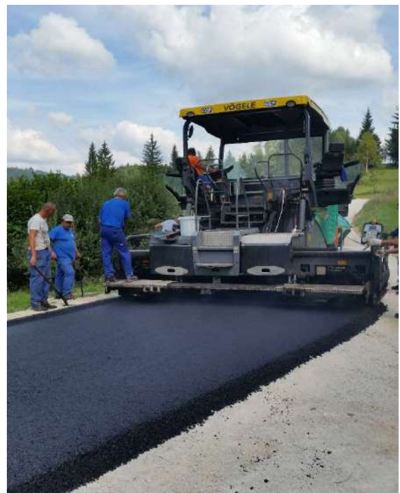
Asfaltiranje občinske ceste na Sedlo.
