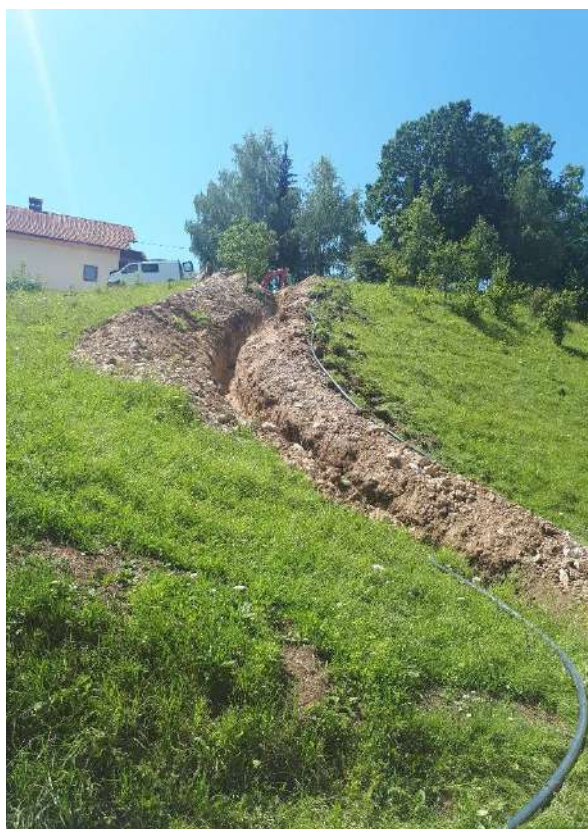
Gradnja novega vodovoda v Malem Zapotoku.
