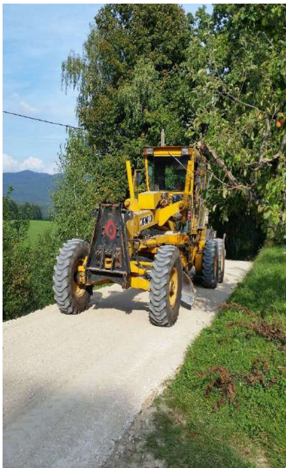
Gredanje in asfaltiranje občinske ceste v Malem Zapotoku.
