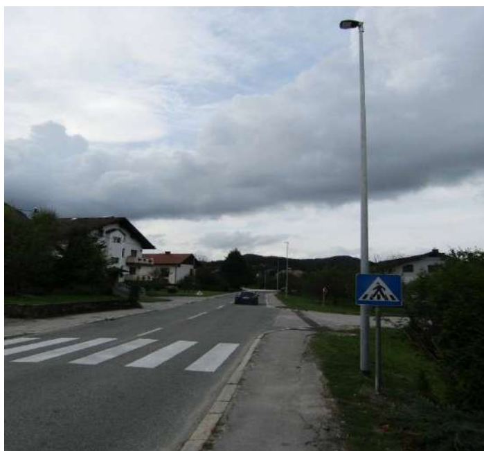
Novo postavljena javna razsvetljava na cesti Notranjskega odreda v Sodražici.
