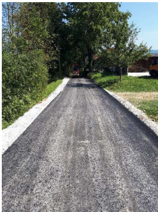
Gredanje in asfaltiranje občinske ceste v Malem Zapotoku.
