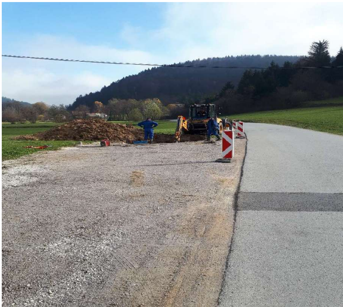
Navezave vrtin v Izberju na novo vodovodno omrežje jeseni 2020.
