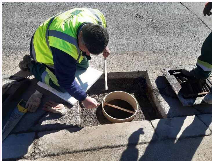
Slika 40: Popravilo vtočne rešetke
