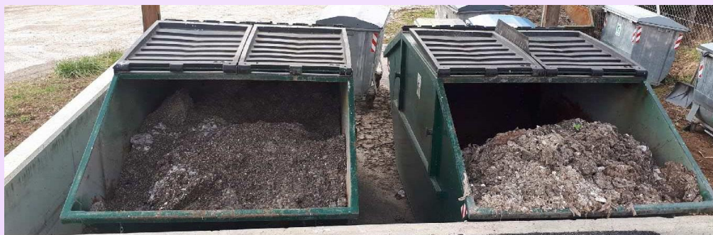
Slika 18: Zaboyniki za začasno skladiščenje odpadkov iz grabelj, sit in peskolova
