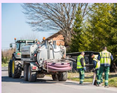
Slika 25: Čiščenje kanalizacije
