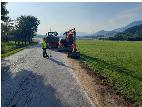
Slika 41: Vzdrževanje cest – urejanje bankin
