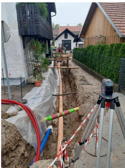
Slika 44: Izgradnja dodatne kanalizacije in vodovoda na Struški ulici
