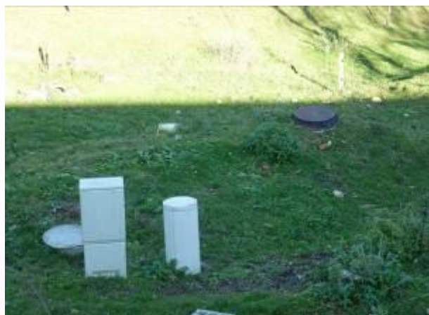
Slika 22: Mala čistilna naprava Novi Pot
