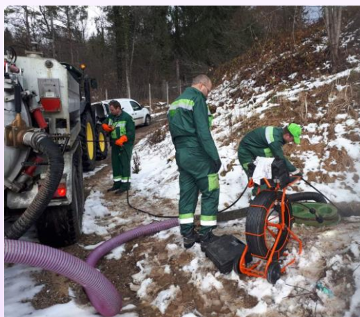
Slika 15: Snemanje in čiščenje vrtine za izcedne vode iz deponije nenevarnih odpadkov Mala gora
