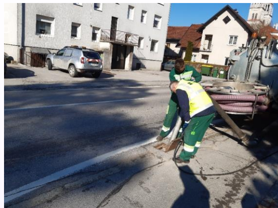
Slika 42: Čiščenje peskolovov
