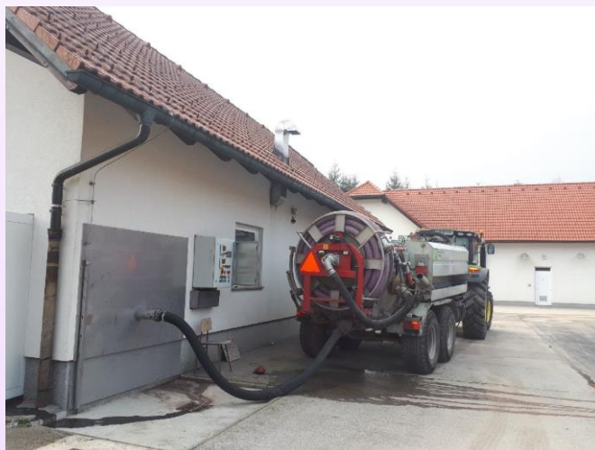
Slika 26: Praznjenje cisterne v zalogovnik grezničnega blata na ČN Ribnica
