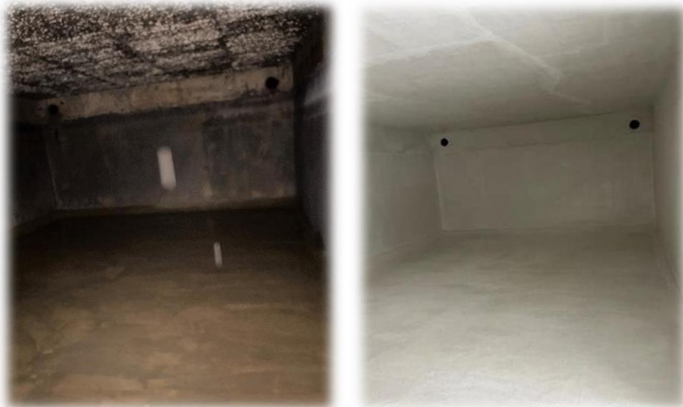
Slika 1notranjosti vodne celice pred in po obnovi
