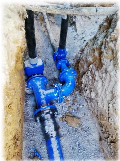
Navezava novega cevovoda na stari cevovod
