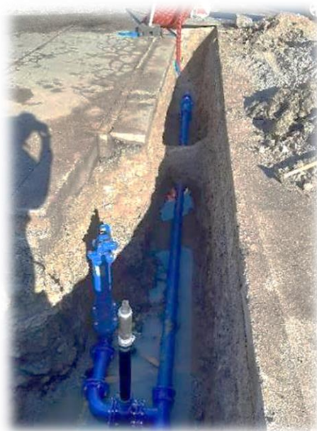
Obnova cevovoda Čolnarska ulica
