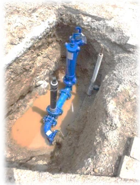
Vgradnja novega talnega hidranta v Gornjih Lepovčah
