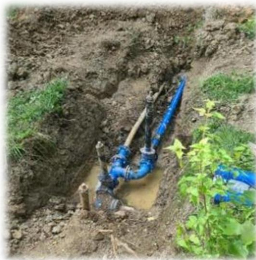
Slika navezave na stari cevovod Petrina - Grivac
