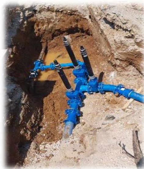
Navezava na obstoječi vodovod- Streliška ulica
