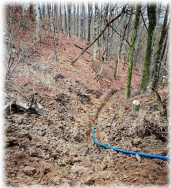
Prestavitev cevovoda v Kočevski Reki
