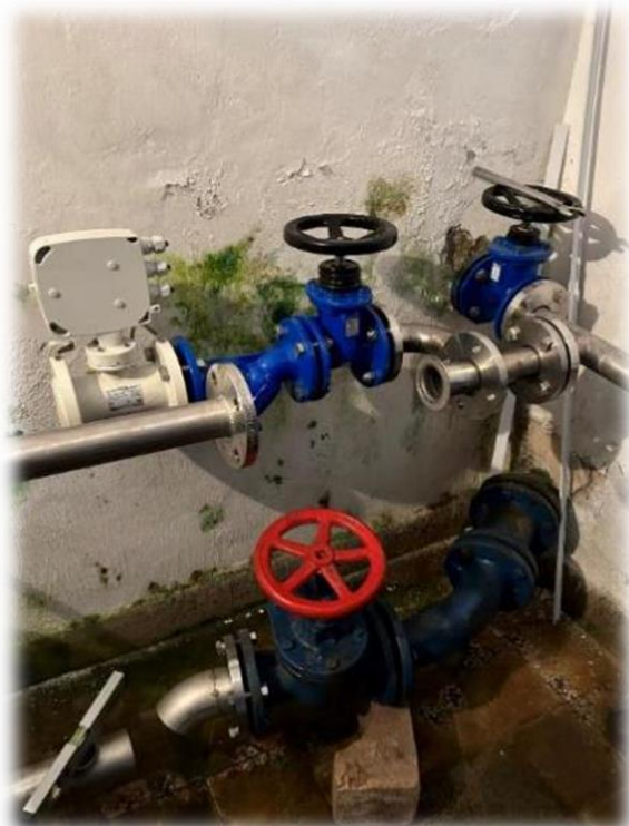
Slika izvedene predelave v VH Hrib
