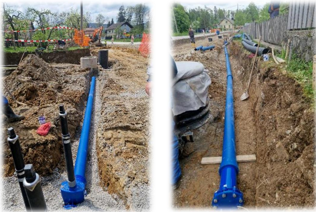
Obnova cevovoda v naselju Gorenje
