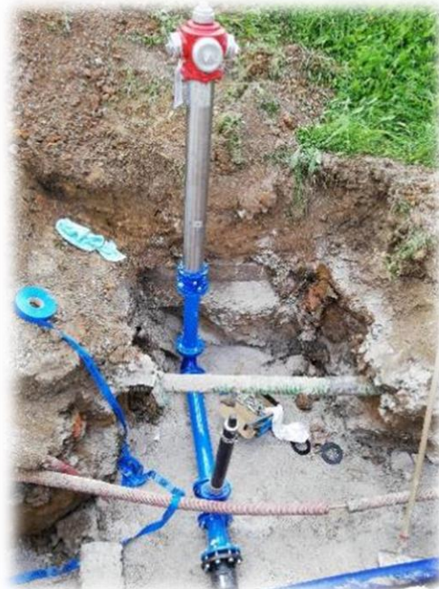
Vgradnja novega nadzemnega hidranta
