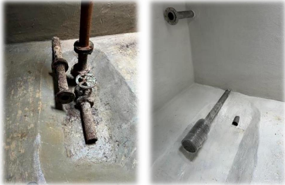
Slika elementov vodovoda v celici pred in po obnovi
