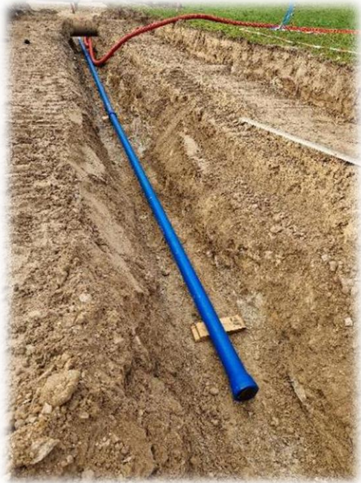
Obnova cevododa Hrib - Travnik
