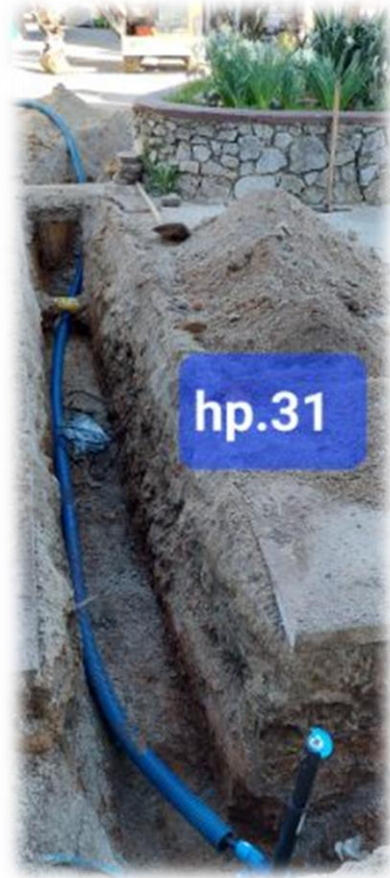
Obnova cevovoda v Konca vasi
