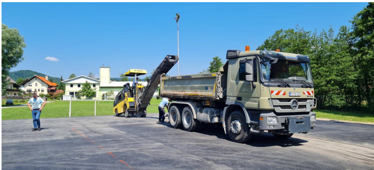
Obnova asfaltnega igrišča v Sodražici.
