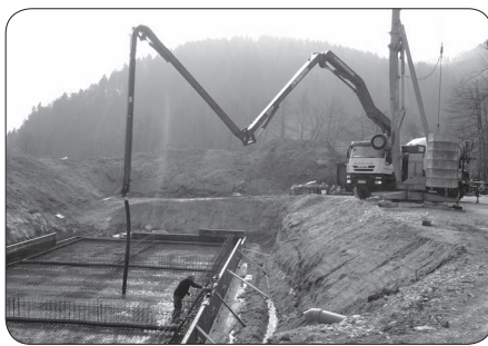
Betonaža temeljne plošče ČN Sodražica
